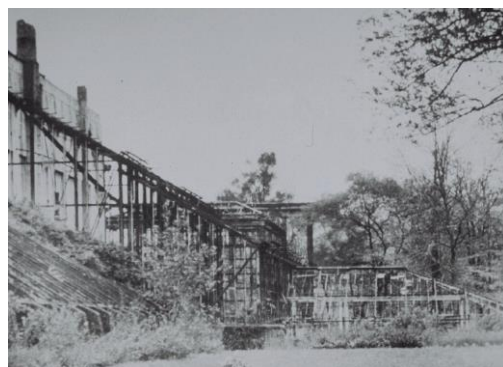
Zniszczone szklarnie po 1945 r.
